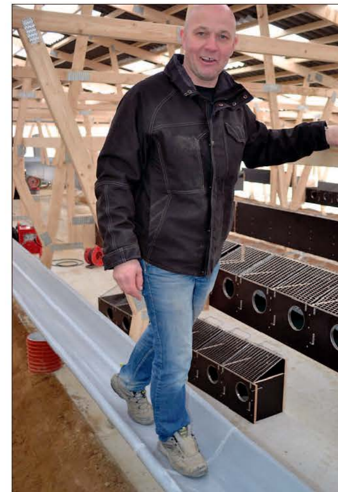
Thyrrstrups nye gyllerende svejser i samlingerne, så der ikke er nogen ujævnheder, når skraberer kører gennem renden. Bredden er 41,5 cm, og forstærkninger på undersiden gør den så stærk, at man kan gå i den. Foto: Einar Bo Thomsen.
